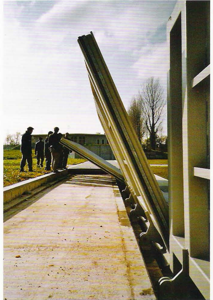
Bild 2 Das System HS-3 wird aufgestellt – die Anstauhöhe beträgt 2 m. (Fotos: KWS System-Technologie)
